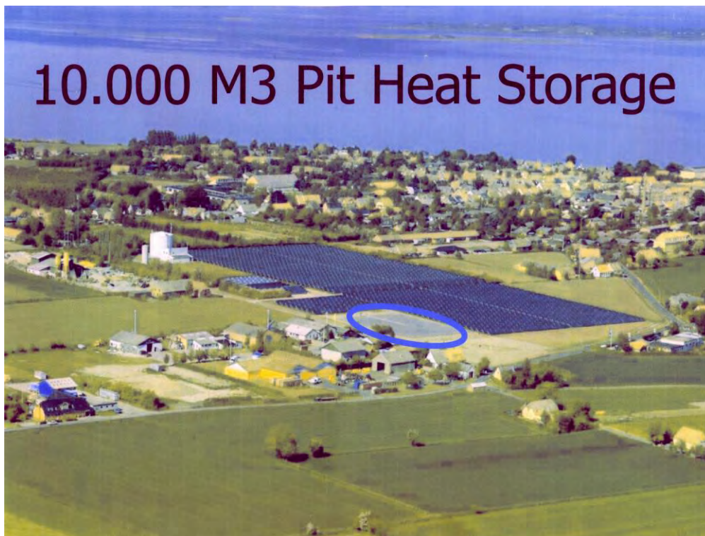
Abb.43: Große Solarwärme-Anlage in Marstal / Dänemark. Der blau-oval markierte Bereich ist der Gruben-Wasserspeicher mit schwimmendem Isolierdeckel. Quelle: Leo Holm (62)
