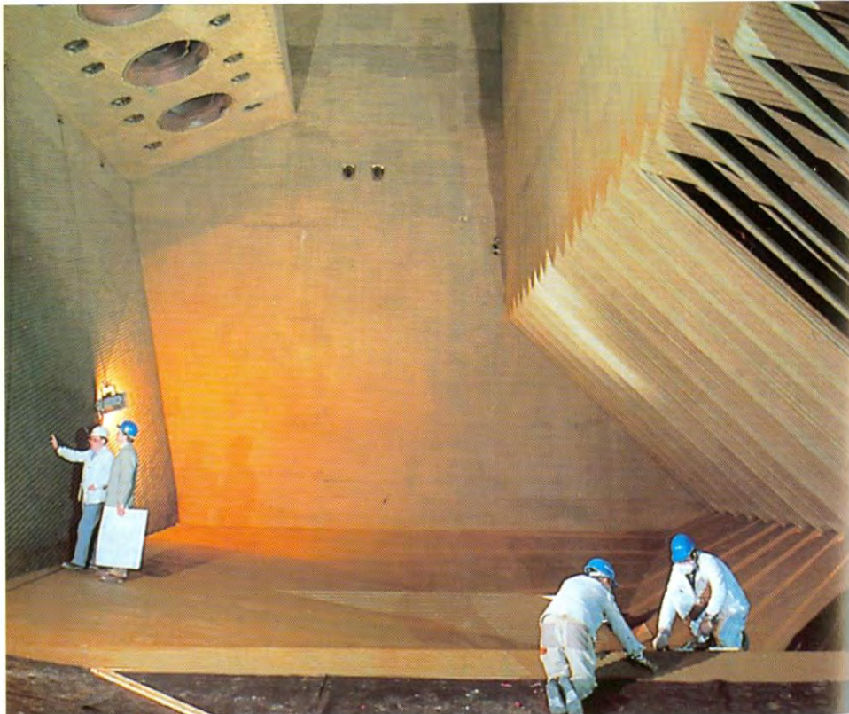
Stufenschmelzkammer eines 770 MW Dampferzeugers (um 1990).
