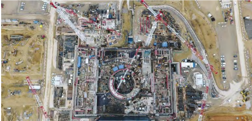
Der Versuchsreaktor Iter aus der Luft Quelle: Fusion for Energy
