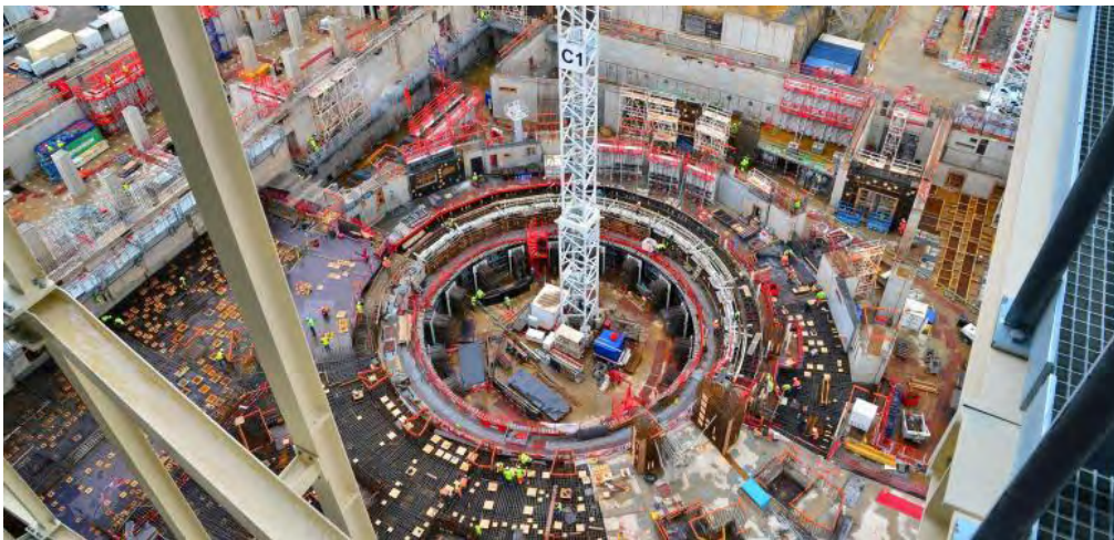
Bauarbeiten am Forschungszentrum Cadarache Quelle: Fusion for Energy
