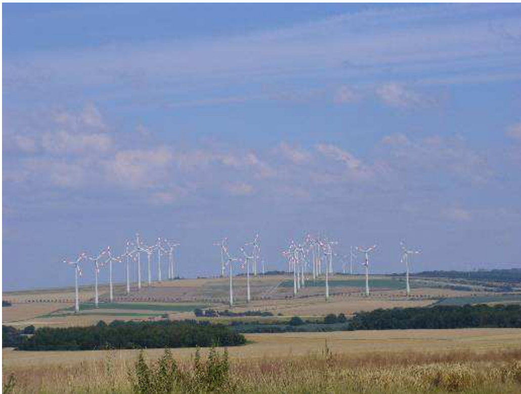
Abb. 3-6: WP Druiberg. Blick von Nordwesten auf den Windpark, deutlich sichtbar die Doppelreihe der WKA.
