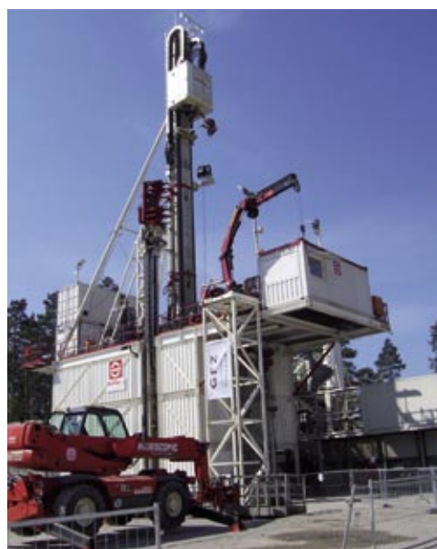
Bohrturm in Groß Schönebeck: In dem brandenburgischen Ortsteil der Gemeinde Schorfheide soll ein Geothermie-Kraftwerk mit einer elektrischen Leistung von 0,75 MW entstehen.
